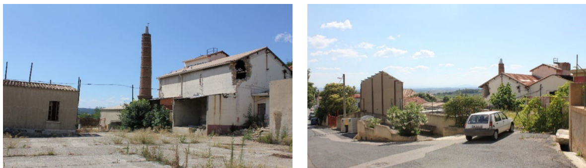
Figure 10 : Exemple de friche industrielle à Quarante
