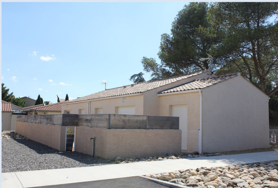
Figure 37: Logements communaux de Quarante - Source : AURCA
