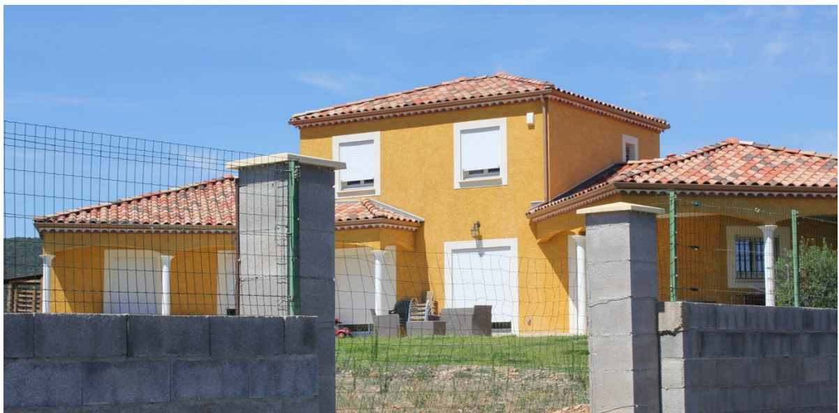
Figure 41: Une construction récente à Cessenon-sur-Orb
